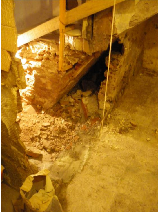
1. Vista general de la zona on s'havia de fer el fossat.
