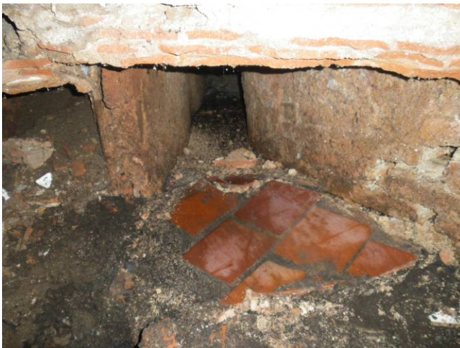
7. Detall de la claveguera UE -7 que servia de desaigna.
