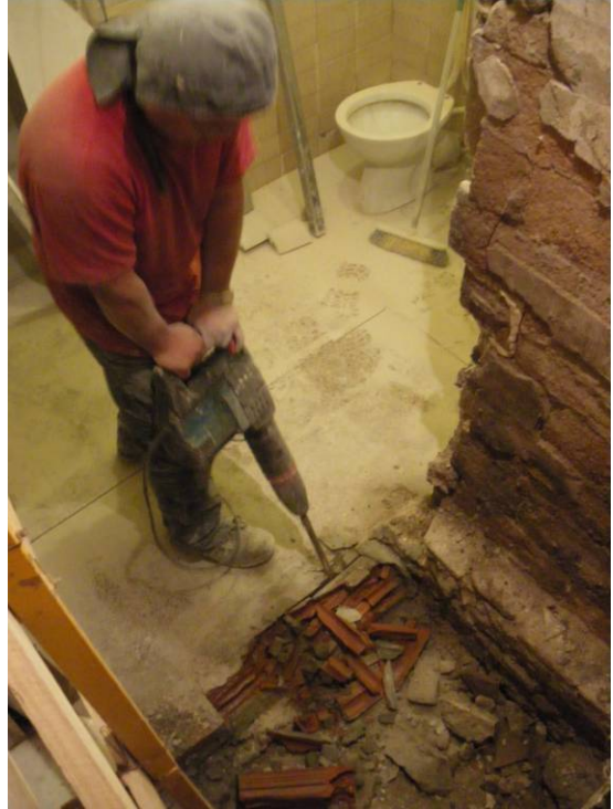
2. Operari treien el paviment (UE 1)
