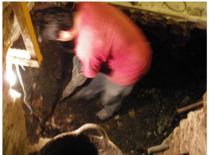
8. Desmuntatge de la solera de les clavegueres.
