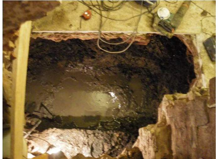
10. Fossat acabat ja a cota per fer el forat de l'ascensor.
